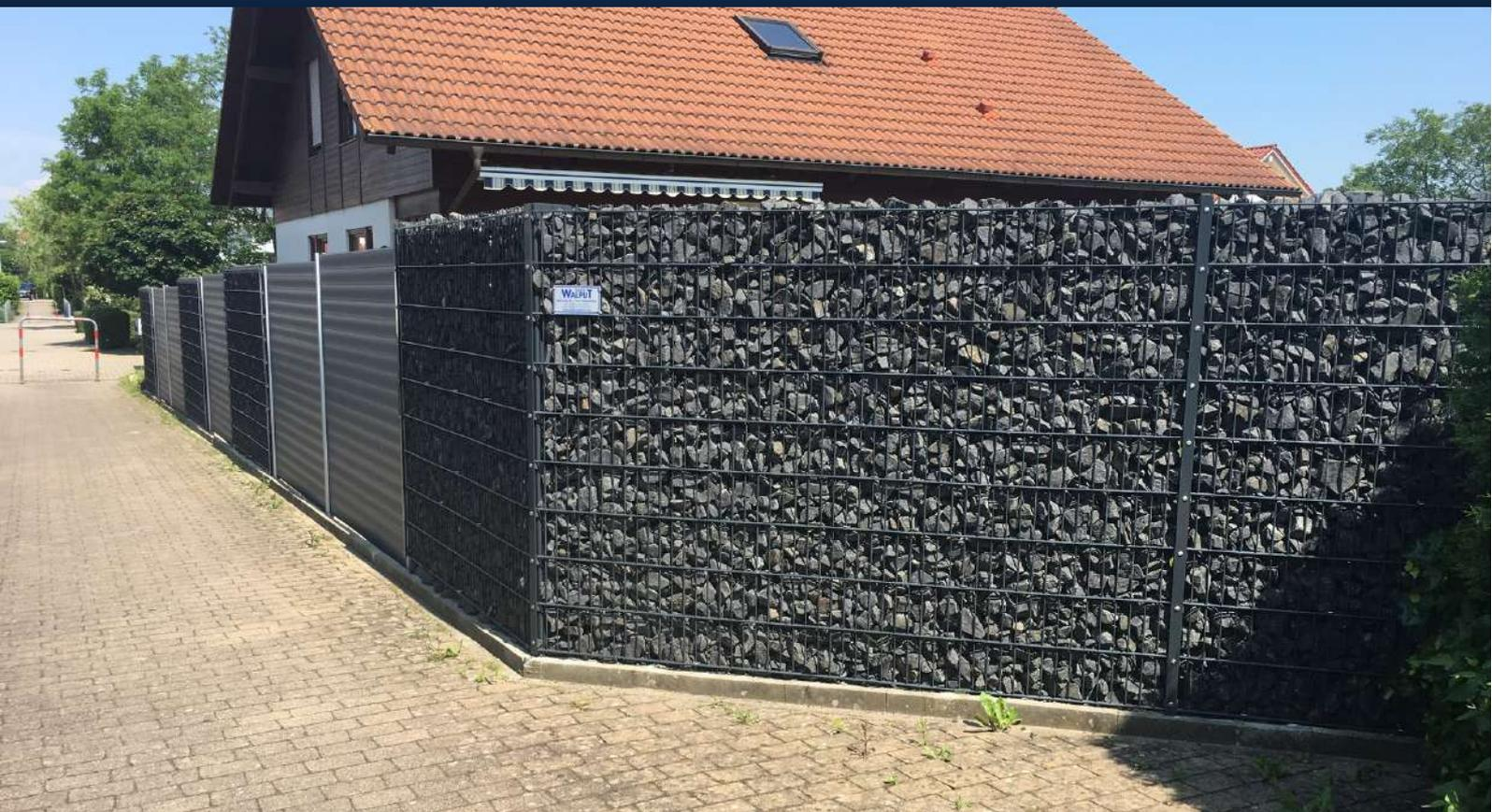
Für unser Gabionenprogramm ist der Doppelpfosten der Klassiker und in seiner Anwendung und Montage sehr einfach.
